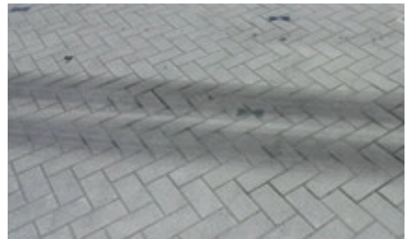
대일텍 3D-HOLE블록 시공사진
