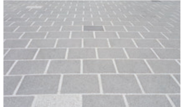
대일텍 3D-HOLE블록 시공사진
