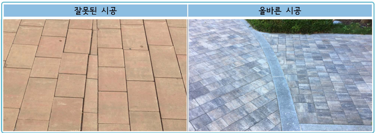
<그림 4-5> 절단블록을 이용한 결절부 처리
