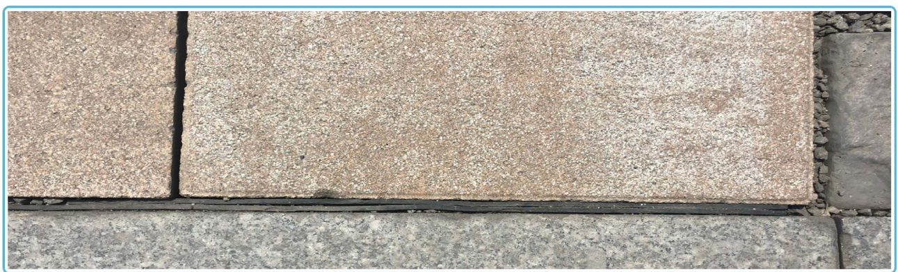
<그림 4-7> 고무 완충재 시공 예시
