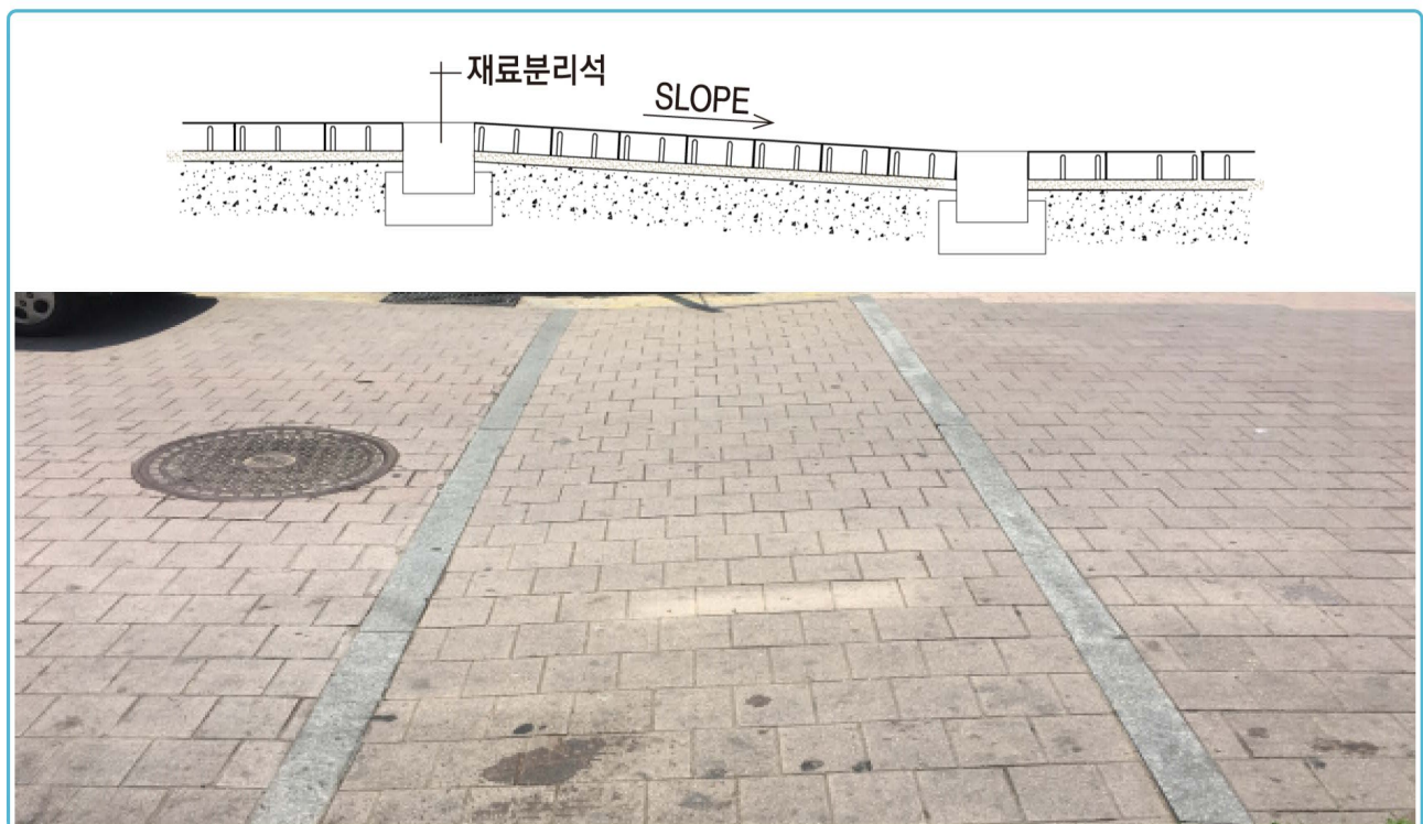
<그림 4-14> 과속방지턱 재료분리석 시공 예시
